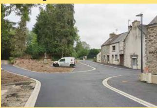
Les travaux de préparation ont été terminés fin mai : eau pluviale, bordures, terrain de Boules... L'enrobé «voirie» a été réalisé le 2 juin. Il restait à réaliser des mises à niveau de tampons, des travaux de signalisation routière et la réalisation des espaces verts. La fin des travaux était prévue pour la fin juin.
